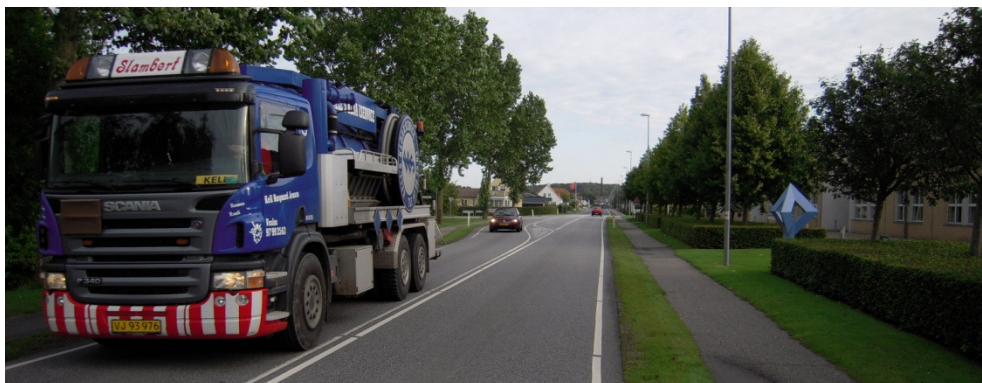
Figur 19 Eksempel på cykelsti langs Aggersundvej i Fjerritslev. Cykelstier i byområder etableres oftest med kantstensopspring mellem kørebanen og cykelsiten.
