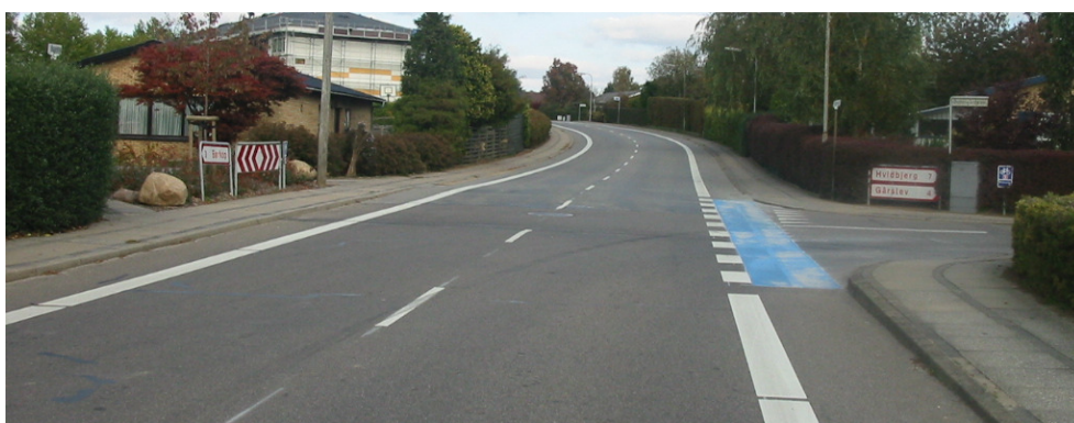
Figur 20 Eksempel på cykelbane markeret med blåt felt (foto fra Brejning ved Vejle).
