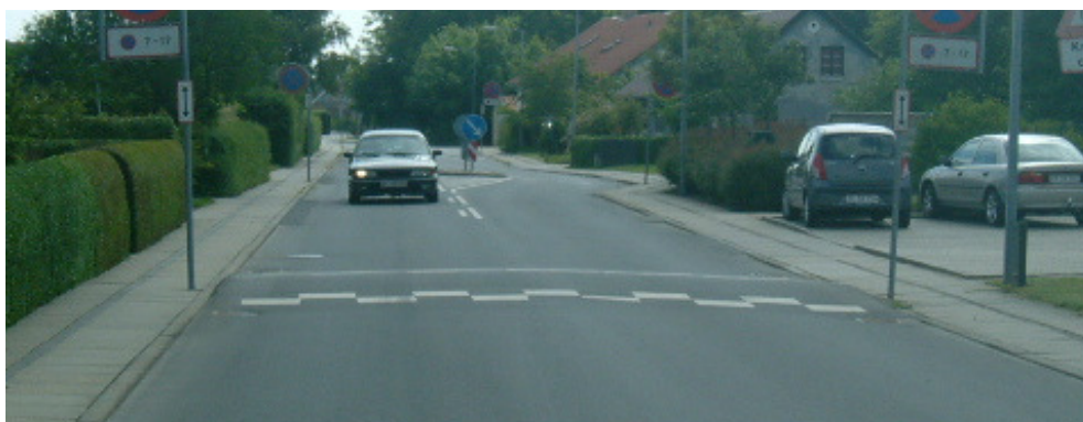
Figur 18 Hastighedsdæmpningen bør etableres med enten bump eller hævede flader for at opnå en effektiv hastighedsdæmpning. Billedet viser hastighedsdæmpning med bump på Cannerslundvej i Pandrup.
